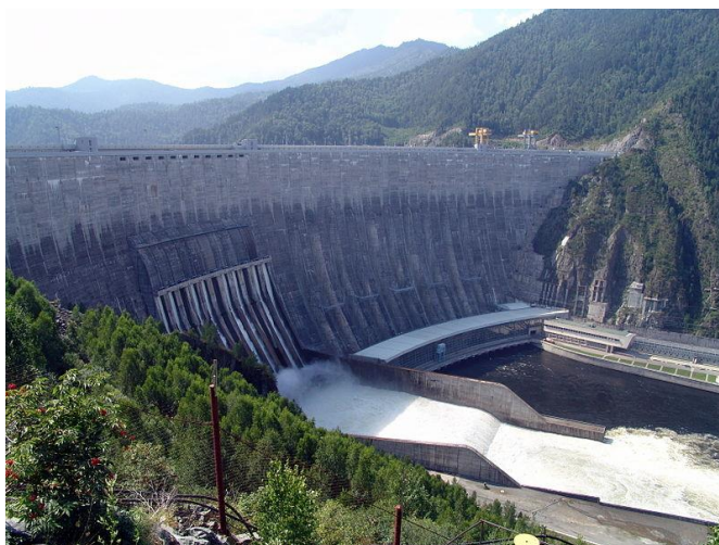
Эксплуатационный водосброс Саяно-Шушенской ГЭС в действии (2010)
